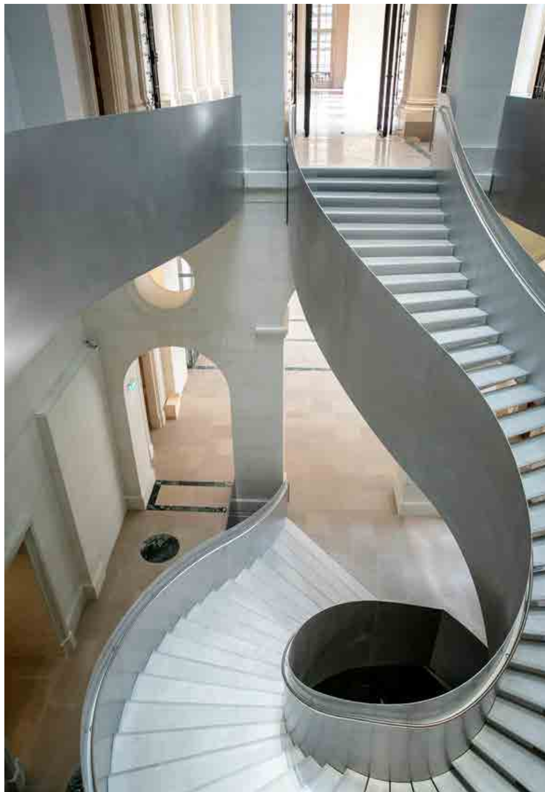
L'escalier d'honneur, en acier et aluminium, a été installé au cœur du site. Laurent Julliard/BnF
